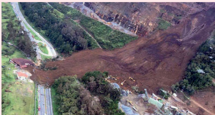
Derrumbe en la carretera Bogotá-Medellín Fuente: Revista Semana
